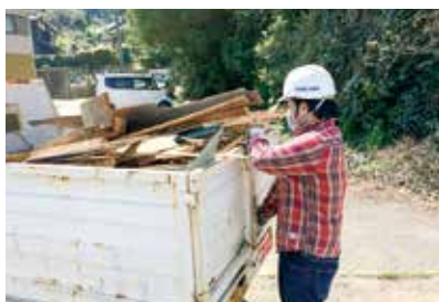
株式会社加藤土木解体 仕分け作業
