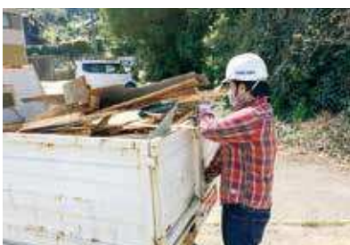
株式会社加藤土木解体 仕分け作業
